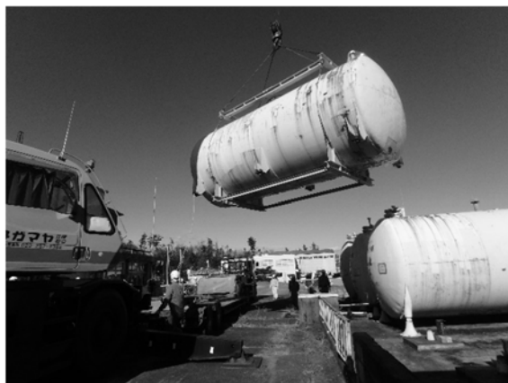
移動式クレーンを用いての吊り上げ
