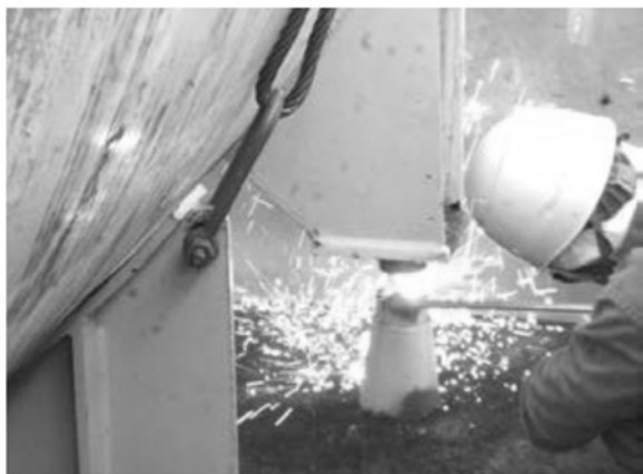
ガス溶断で脚部の切断
