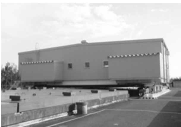
図 3.6.1-5 保管体取出装置（上屋）の外観
