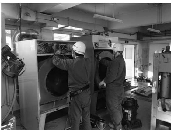
大型乾燥機の解体作業状況
