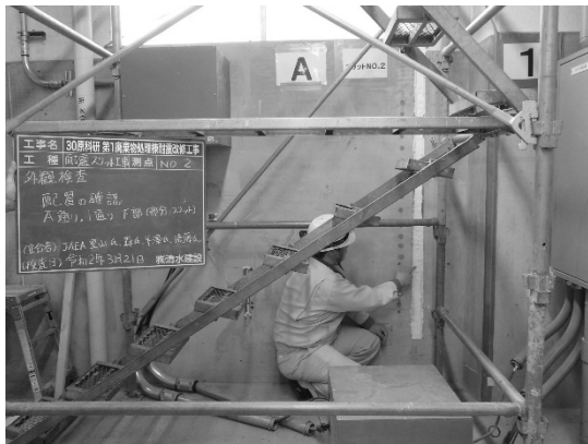
耐震スリットの施工状況
