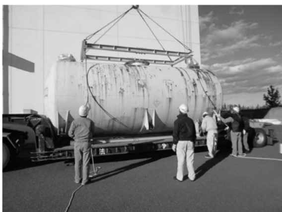
解体分別保管棟解体室への搬入
