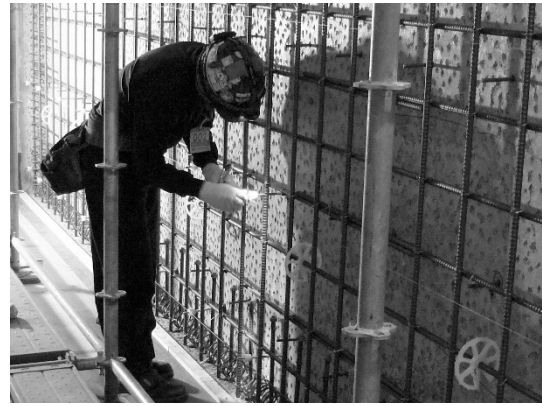
壁の増し打ちの配筋作業
