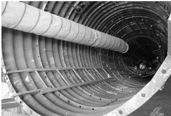
杭基礎の施工状況
