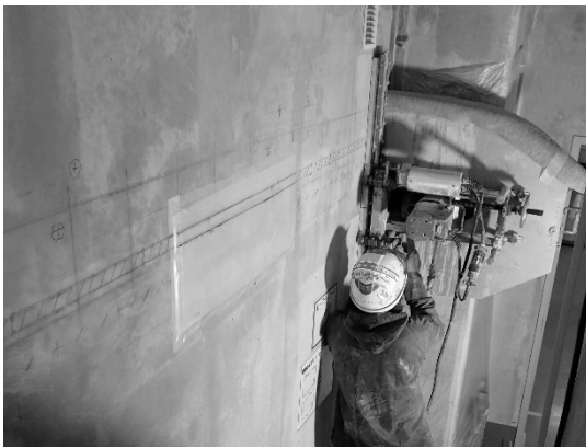
耐震スリットの施工状況
