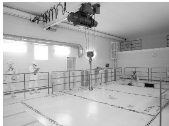
図 3.6.1-6 上屋の内観（天井クレーン含む）
