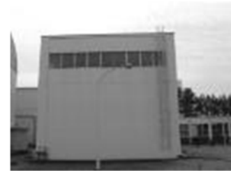
保障措置技術開発 試験室施設 (SGL)
