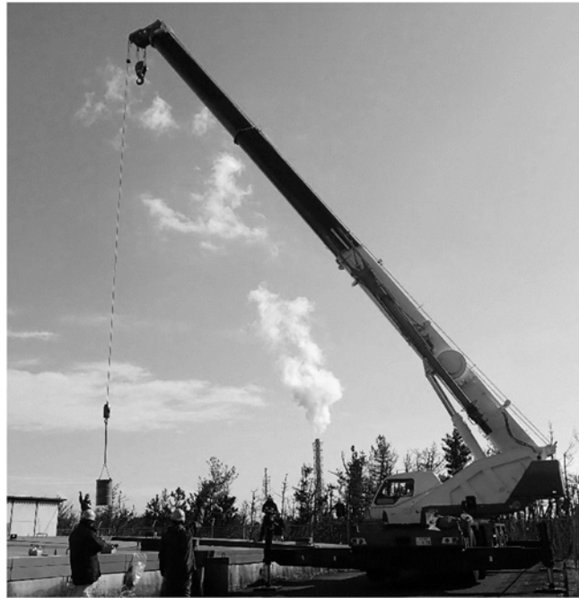
図 3.6.1-8 移動式クレーンを用いた取出しの状況
