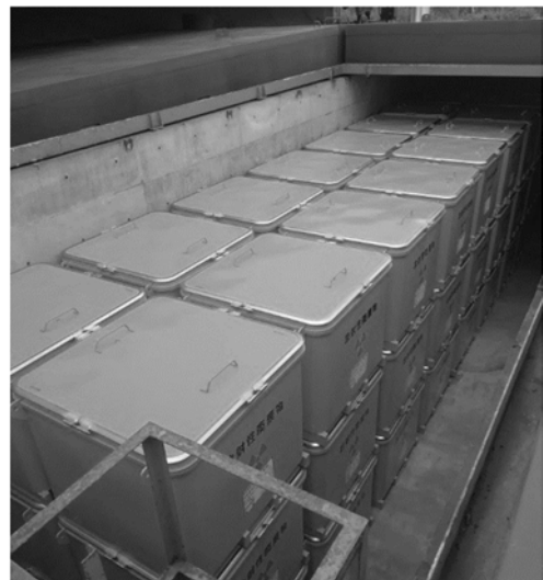
ピットへのS-III容器収納状況
