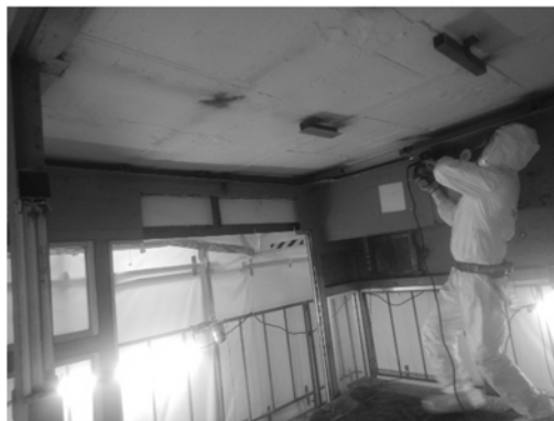
フード H-7 の天井フレームの切断
