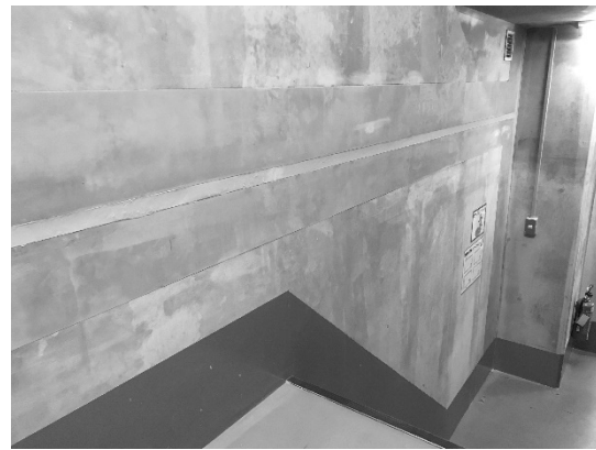
耐震スリットの施工後
