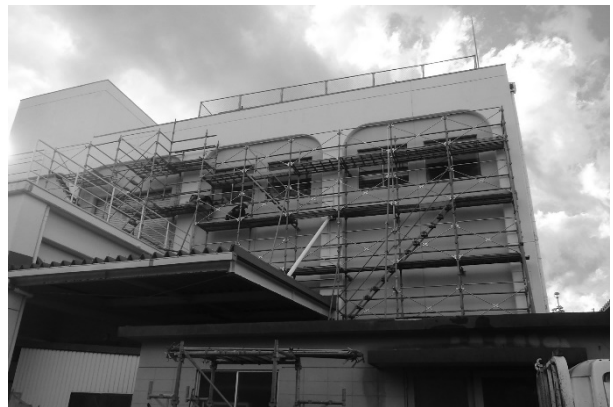
開口閉塞の施工状況
