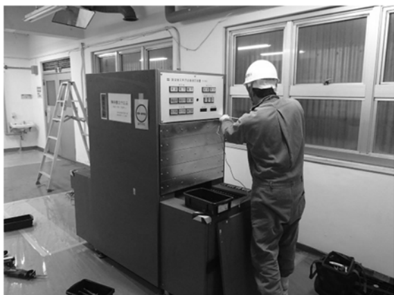
衣料モニター装置の解体作業状況
