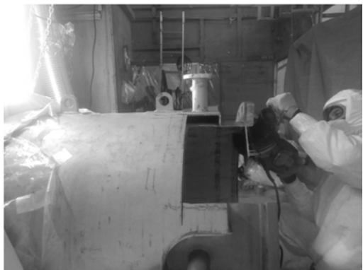
焼却炉の切断
