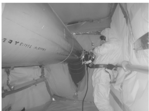
排気 24 系統排気ダクトの切り離し
