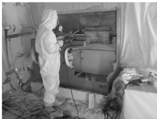
フィルタユニットの細断
