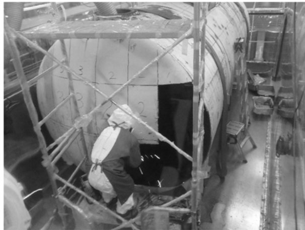
図 3.4.2-3 廃液貯槽の解体処理状況
