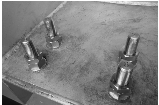
焼却炉ボルトの施工状況
